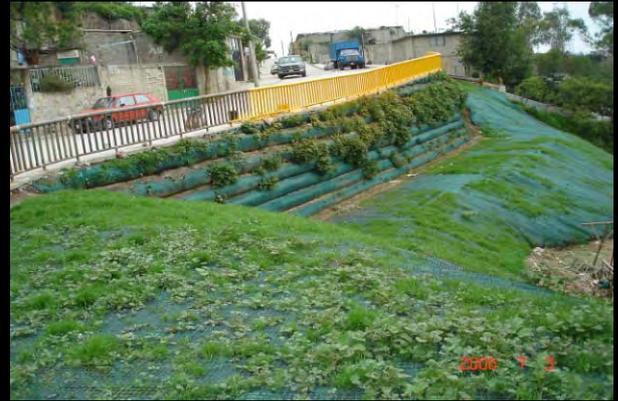
**DESPUÉS:** muro con cara vegetada que soporta la vialidad; sistema de mallas protege contra erosión
