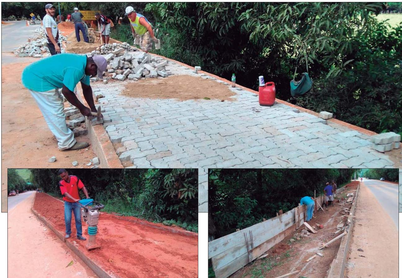
A pista está sendo ampliada em 184 metros lineares de extensão, com calçamento em bloquetes intertravados. O projeto define, inclusive, um sistema de drenagem de água pluvial bem elaborado, que se distribui no percurso da ampliação e fornece excelente sistema de captação e escoamento da água pluvial.
