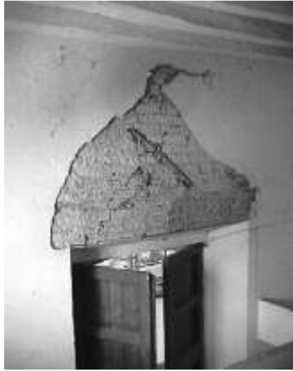
Figura 13. Identificación de intervenciones anteriores con grapas y elementos metálicos — como tensores y crucetas — en muros de carga del inmueble, 2004. Archivo de la SMH-Centro INAH Colima, exp. Templo del Sagrado Corazón, Sismo 2003.
