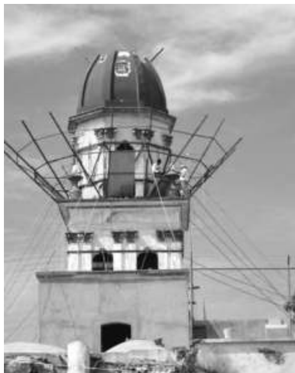
Figura 16. Proceso de demolición del segundo cuerpo de la torre campanario del templo mediante colocación de estructura de protección, 2004. Archivo de la SMH-Centro INAH Colima, exp. Templo del Sagrado Corazón, Sismo 2003.
