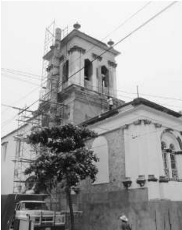
Figura 17. Vista general de la torre después de la demolición del segundo cuerpo de la torre, 2004. Archivo de la SMH-Centro INAH Colima, exp. Templo del Sagrado Corazón, Sismo 2003.
