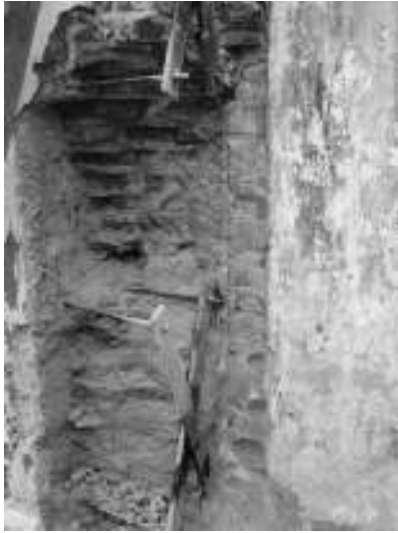
Figura 13. Identificación de intervenciones anteriores con grapas y elementos metálicos — como tensores y crucetas — en muros de carga del inmueble, 2004. Archivo de la SMH-Centro INAH Colima, exp. Templo del Sagrado Corazón, Sismo 2003.
