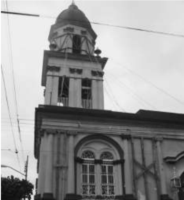
Figura 9. Trabajos preliminares de apuntalamiento en exteriores, fachada y torre campanario, 2004. Archivo de la SMH-Centro INAH Colima, exp. Templo del Sagrado Corazón, Sismo 2003.
