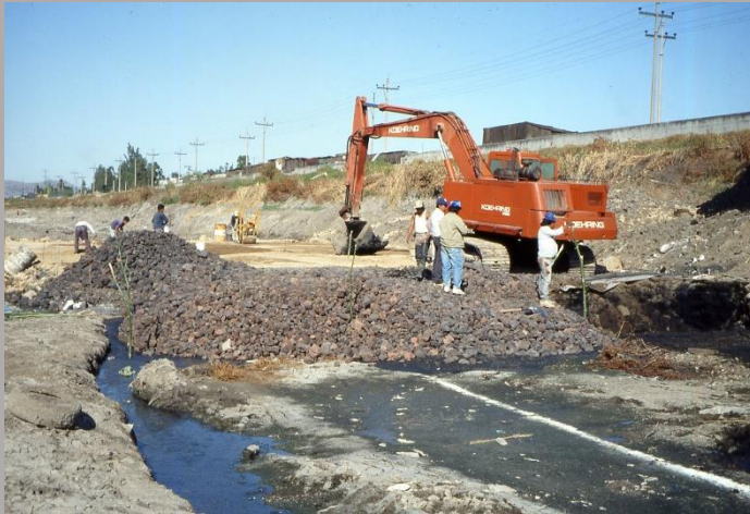
Tramo con tezontle incrustado y vibrado
