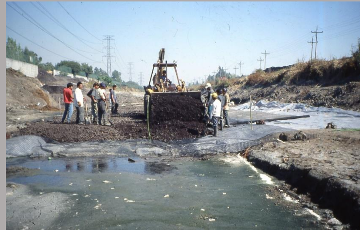
Tramo con PAVITEX TS 400, geomalla y tezontle
