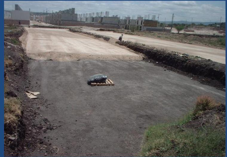
Enseguida se colocó relleno de buena calidad y se ejecutaron las obras de drenaje, para completar las plataformas.
